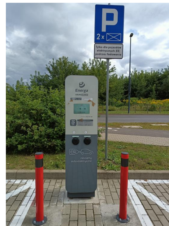
Rys. 2.6 Stacja ładowania pojazdów elektrycznych w Olsztynie
